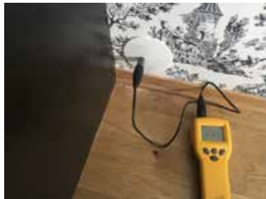
Hulltaking fra soverom. Relativ luftfuktighet 20%.
